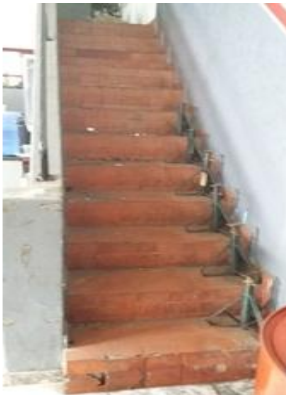
FIGURA 25 - ILUSTRA O ACESSO AO ALMOXARIFADO ANTES DA RESTRIÇÃO.
